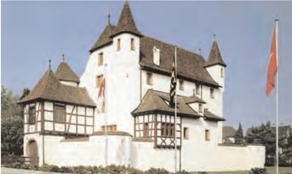
Das Prattler Schloss nach der Renovation von 1967.
