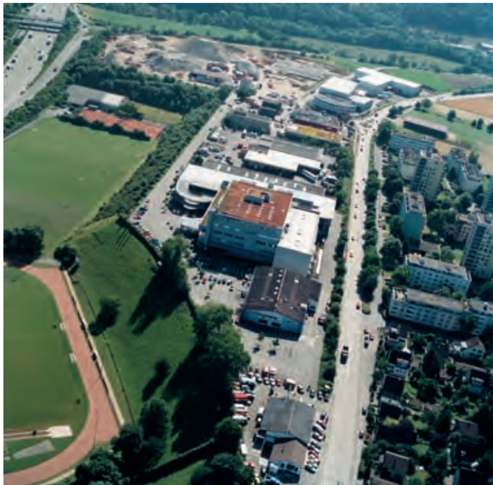
Die Parzellen in den Gebieten Rütli und Wanne, links von der Strasse Pratteln–Frenkendorf, sind von der Bürgergemeinde im Baurecht abgegeben worden. Oben links die Autobahn A2.
