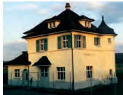
Das 1913 im Jugendstil errichtete Pumpwerk Löli.
